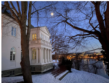
DKNVS har kontorer i 2. etasje i Elvegata 17. NTNU eier bygningen, som har flotte møterom i 1. og 3. etasje. Foto: DKNVS
