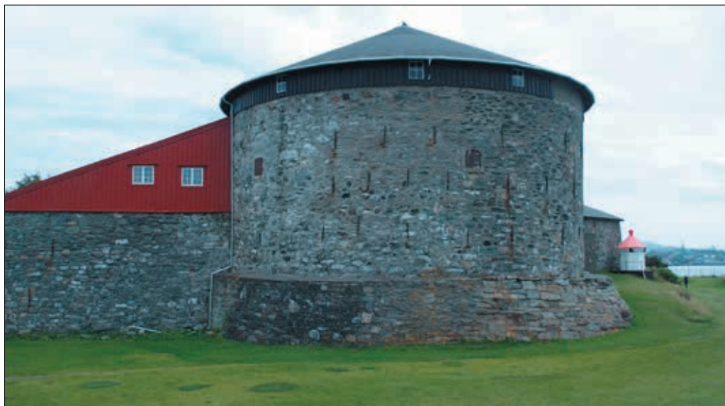
Fig. 2. Munkholmen med rotundens nordside. Foto: Eystein M. Andersen
