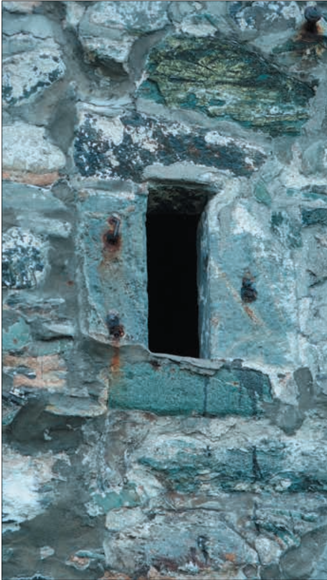
Fig. 15. På rotundens nordside ser vi høyt plassert i første etasjes høyde en liten gjennmurt vindusåpning. Foto: Eystein M. Andersen
