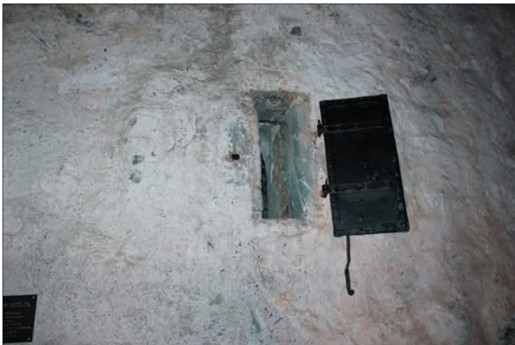
Fig. 16. Vindusåpning i øst under døråpningen. Her er et midtparti inne i åpningen murt med gul tegl før vi ser en buet klebersteinsblokk. Foto: Eystein M. Andersen
