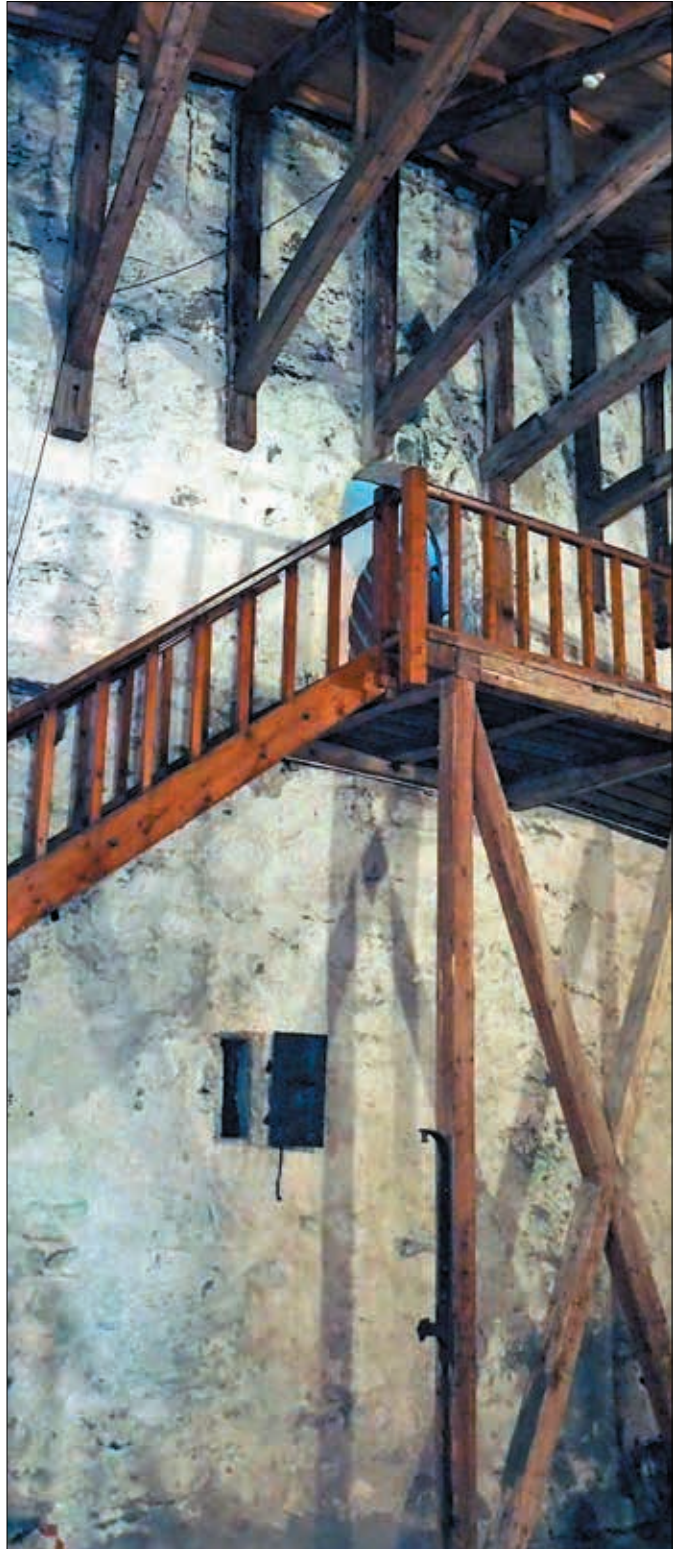
Fig. 11. På dagens rotunde ses nøyaktig i øst en døråpning i kleberstein som kan være fra middelalderen. Den går ut i det fri 4,85 meter over terreng. Under ses en alderdommelig vindusåpning. Foto: Eystein M. Andersen.
