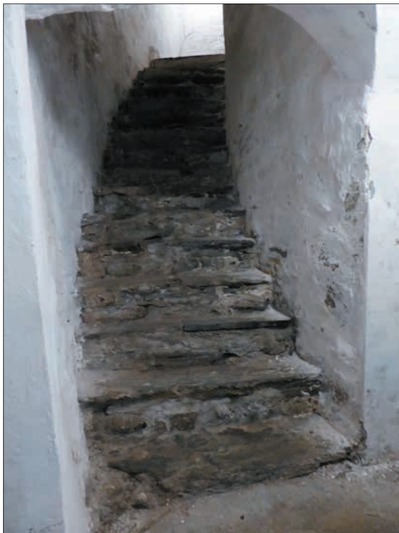
Fig. 17. I rotundens murverk finnes to rette trappeløp med tønnehvelv som følger rotunden i en svak krumming, ett i øst og ett i vest. Foto: Eystein M. Andersen
